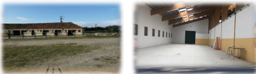
Fig: 23 –Outros exemplos de locais de filmagens. Fonte: Autoria do discente. Local: Companhia das Lezírias e Academia de Dressage. Data: 2020
